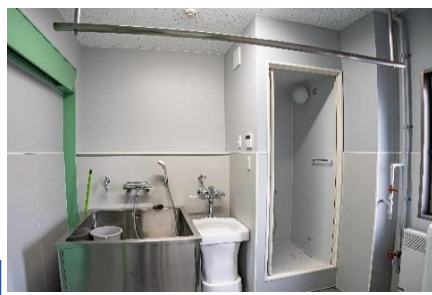
救急洗浄・消毒室
