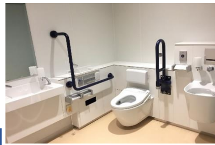
多目的トイレ
